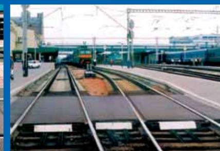
**Технически прогрессивное решение проблемы создания недорогой и долговечной поверхности для безопасного движения автотранспорта и пешеходов через рельсовые пути. К очевидным преимуществам резиновых покрытий следует отнести также отсутствие наледи на поверхности плит, снижение шума от движения и современный дизайн улиц Вашего города!**
